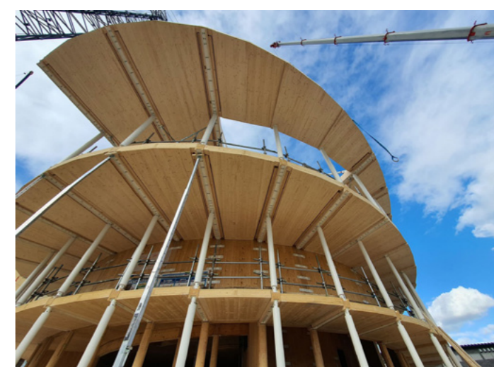
Dokončení instalace systému NOVA TOP
