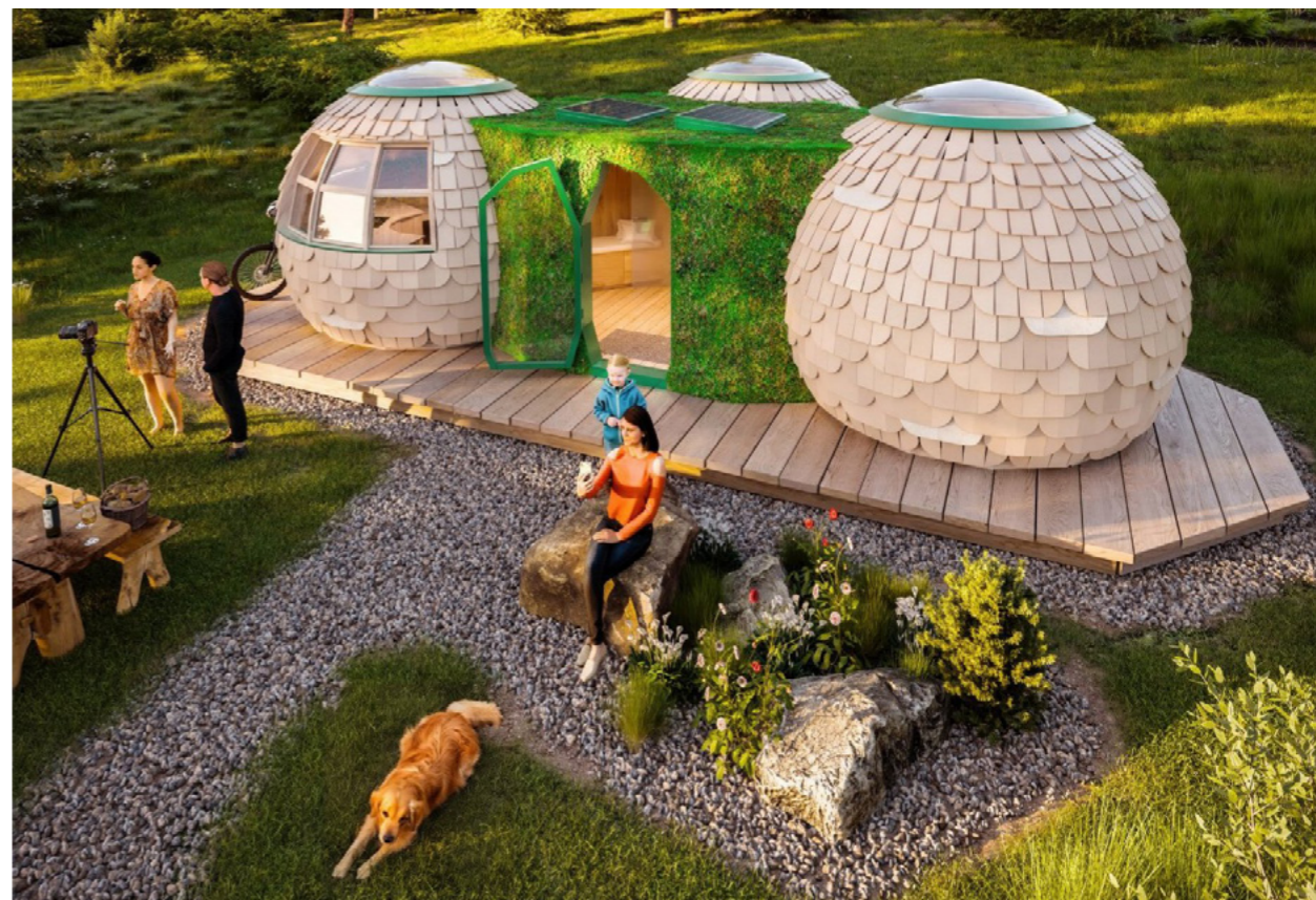
Energie v Samorostu se bude čerpat ze dvou fotovoltaických panelů
