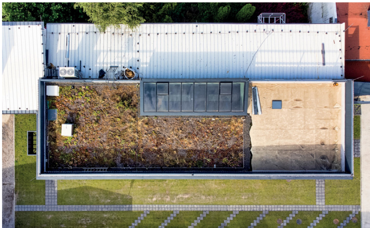
Parkoviště místo původních betonových prvků využívá zatravněvací dlažbu, která umožňuje růst trávy, zasakování vody a brání tak jejímu odtoku do kanalizace
