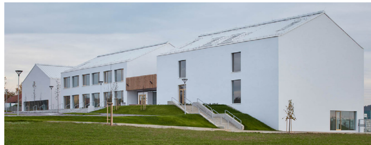
Bílá falcovaná krytina na střeše ZŠ Amos pro Psáry a Dolní Jirčany, 2019 (foto: BoysPlayNice)
