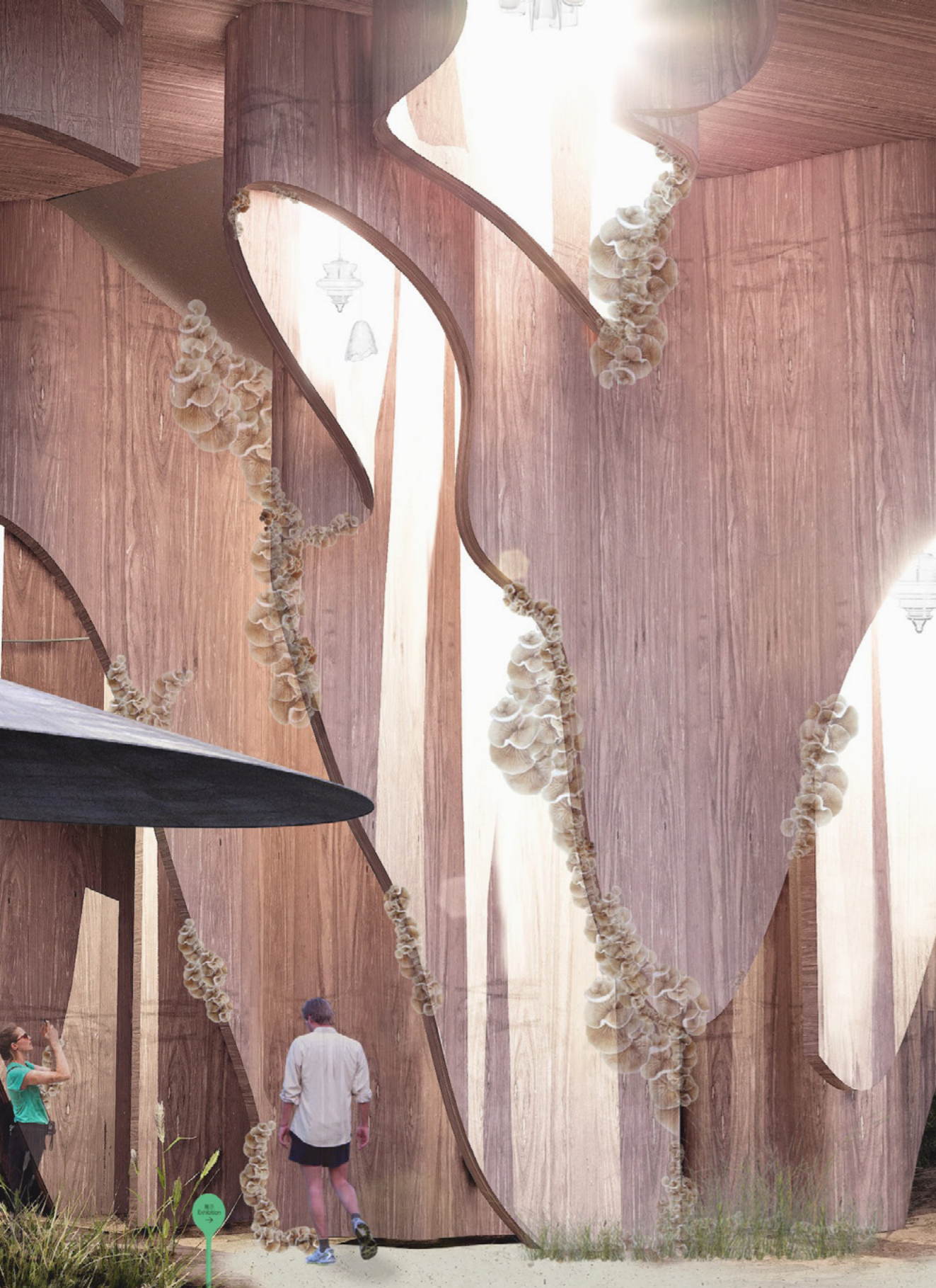
Nosná konstrukce z CLT panelů
