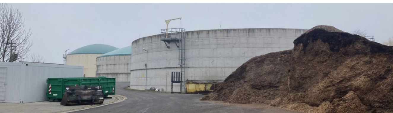
Areál bioplynové stanice.
