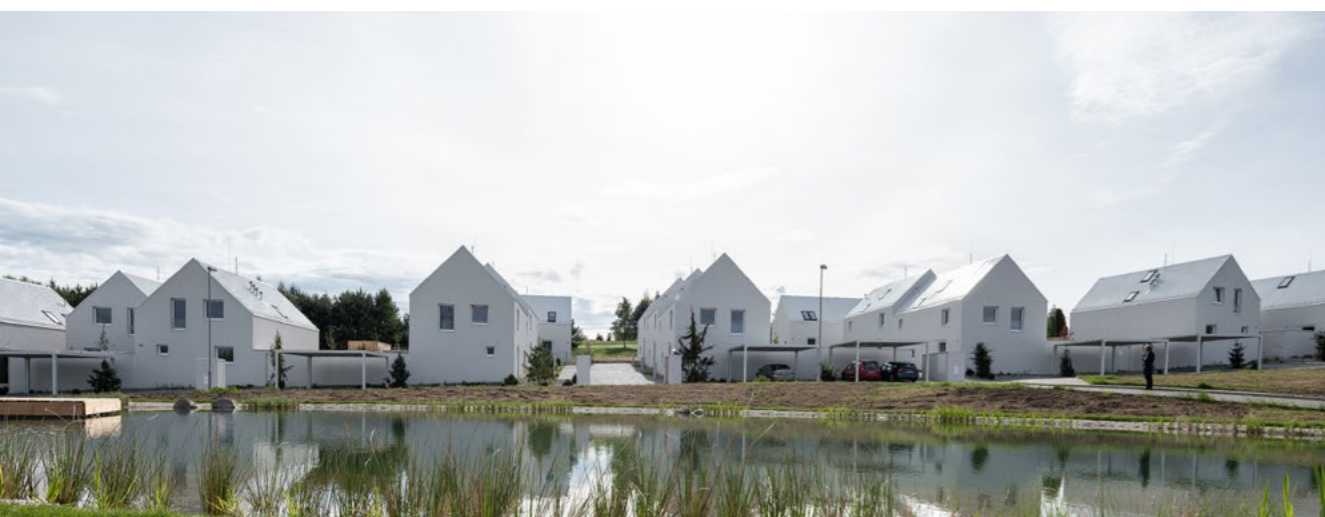
Vesnice má vypracovaný systém hospodaření s dešťovou vodou. Jezero plní dešťová voda ze střech 9 domů.
