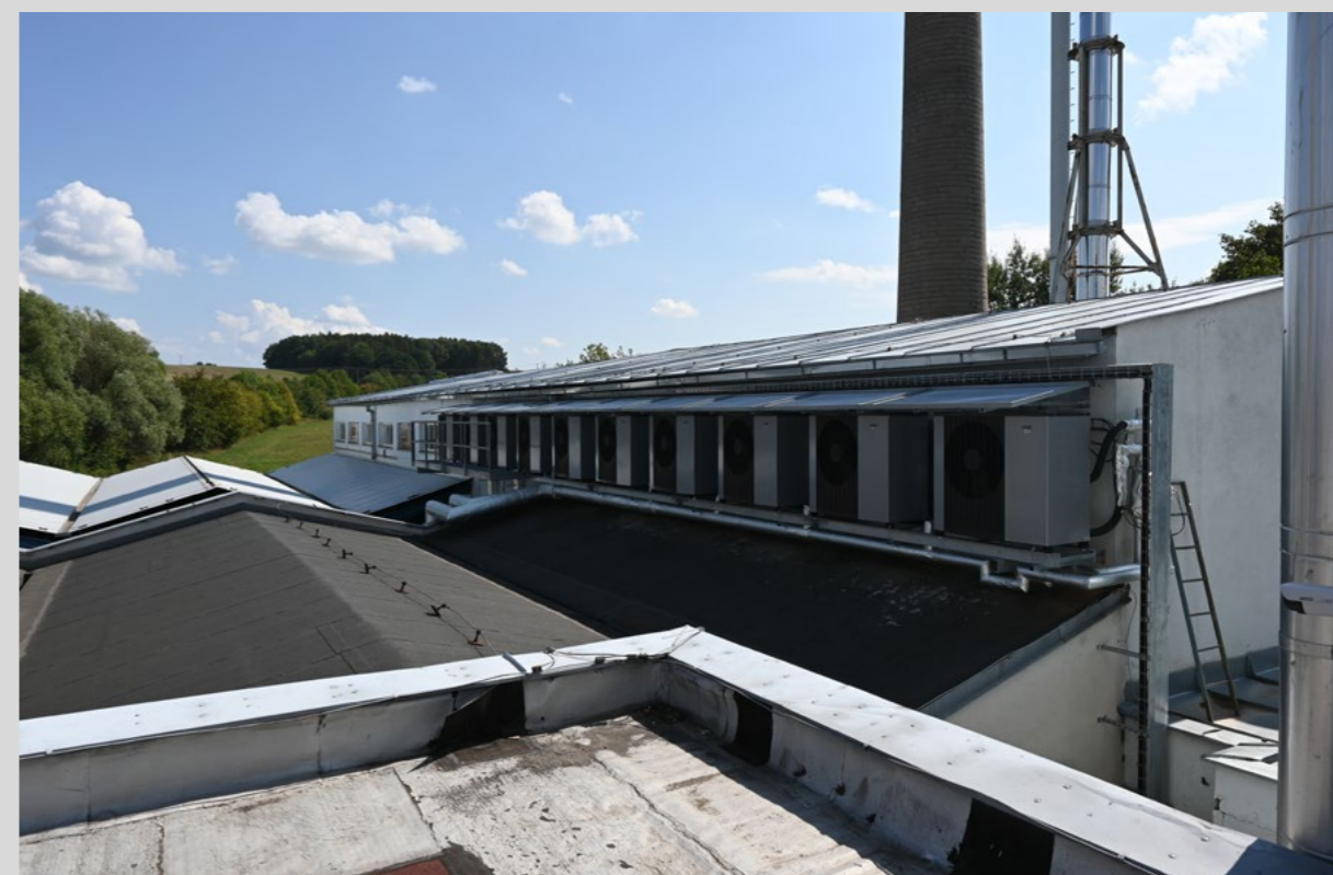
Na střeše kotelny bude instalováno 346 fotovoltaických panelů.
