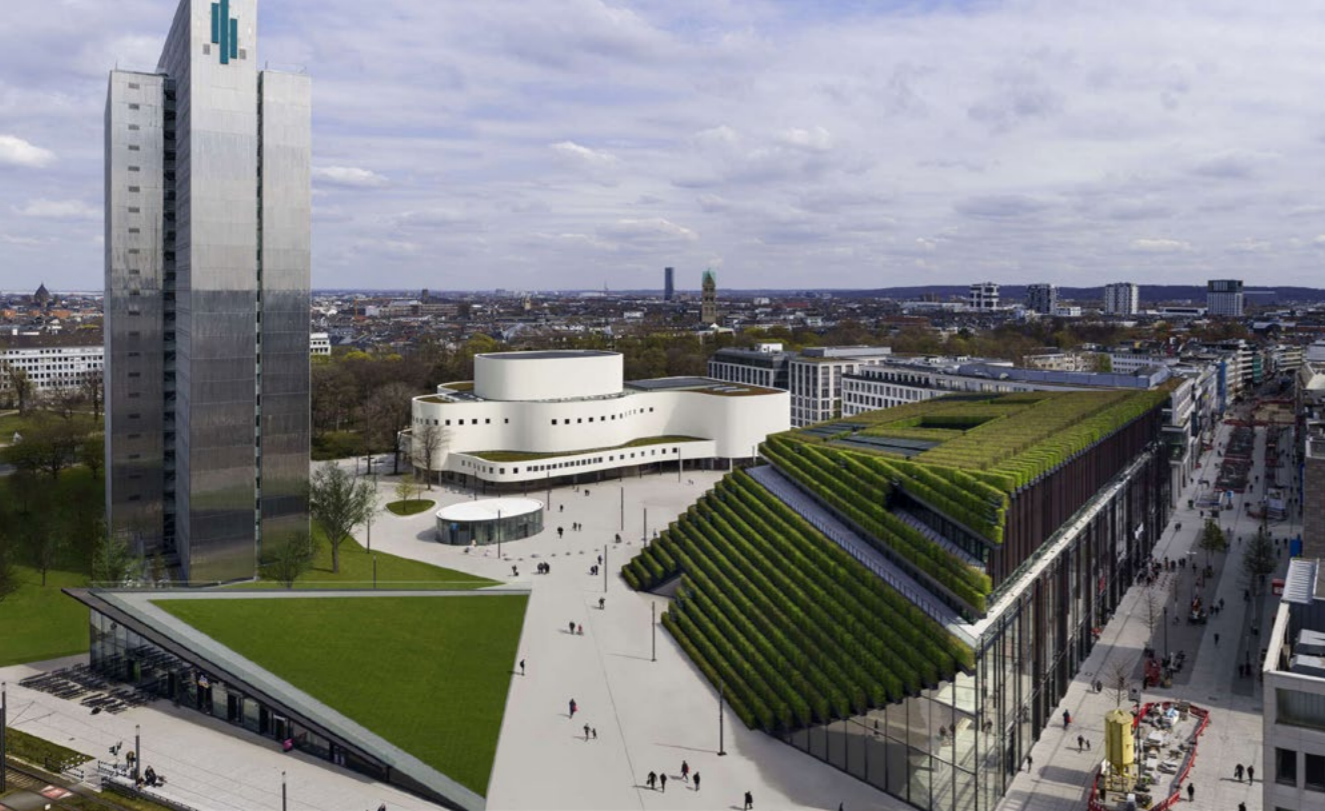
Obchodní a kancelářská budova v Düsseldorfu Kö-Bogen II. Šikmé zelené fasády stojí proti sobě a tvoří vstup na Gustaf-Gründgens-Platz, který otevírá pohled na ikony poválečné moderny Dreischeibenhaus (1960) a Schauspielhaus (1970).
