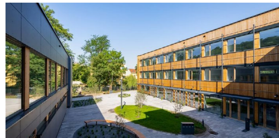
Revitalizace školy Českobrodská v Praze 9
