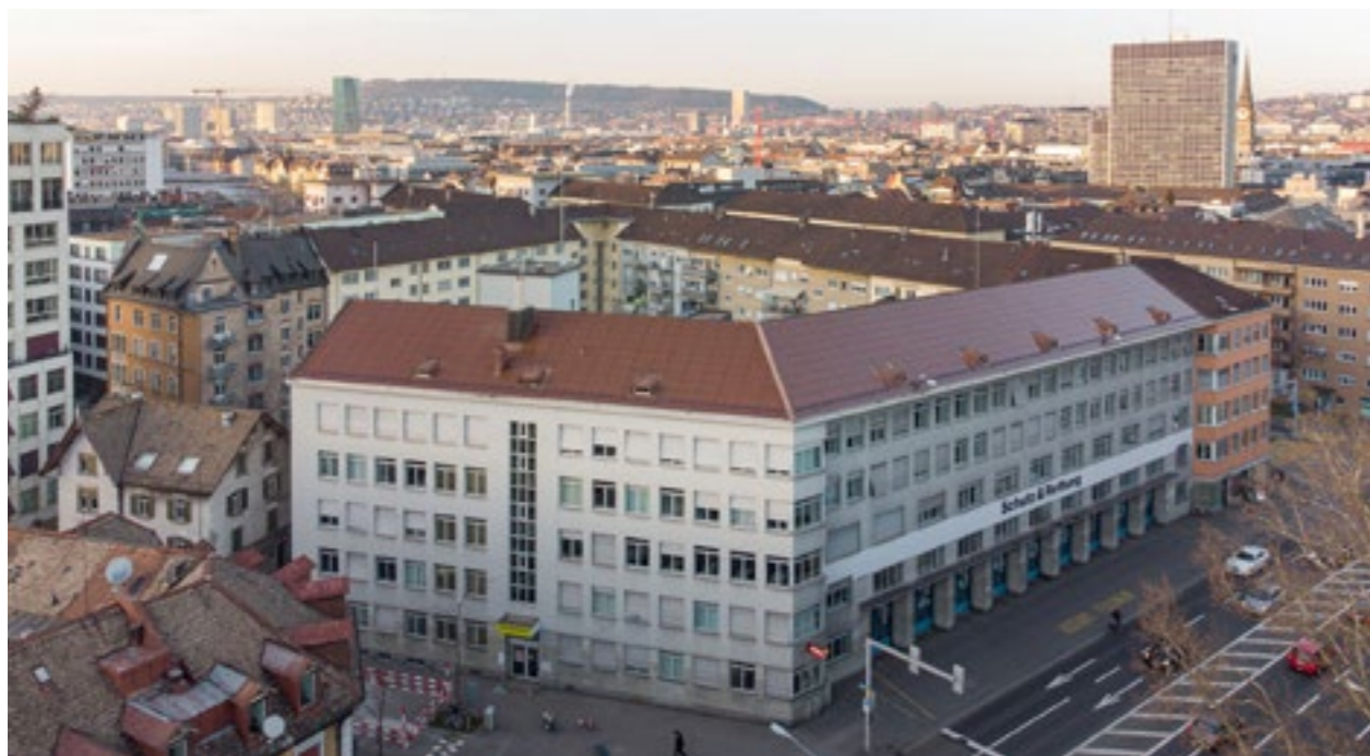
Fotovoltaické tašky s nanofólií na střeše záchranné služby (Schutz & Rettung Zürich) v historickém centru Curychu.
