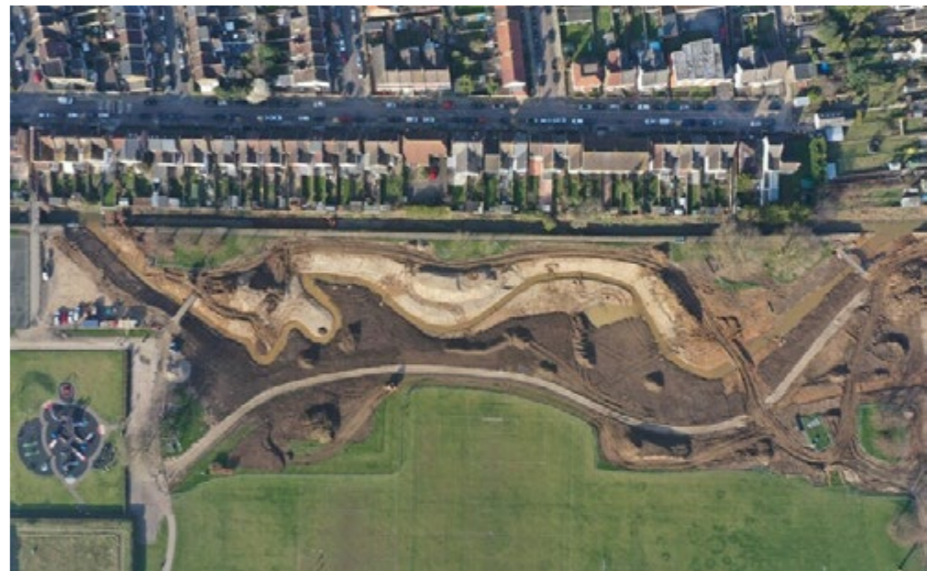
Zásahem do areálu Albany parku v Enfieldu bylo vytvořeno 2 000 m 2 mokřadů a retenční objem se zvýšil na 50 000 m 3 . Návrh. Schéma předchozích záplav území . (Foto: prezentace Jamie Kukadia)
