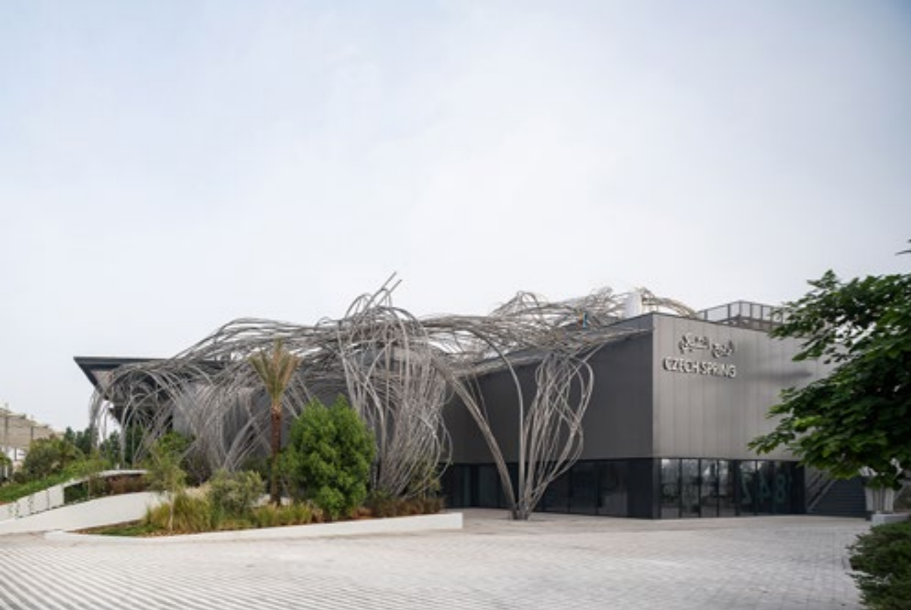
U pavilonu je zahrada stíněná konstrukcí tzv. mraku z ohýbané nerezové oceli, který se promítá i do interiéru.
