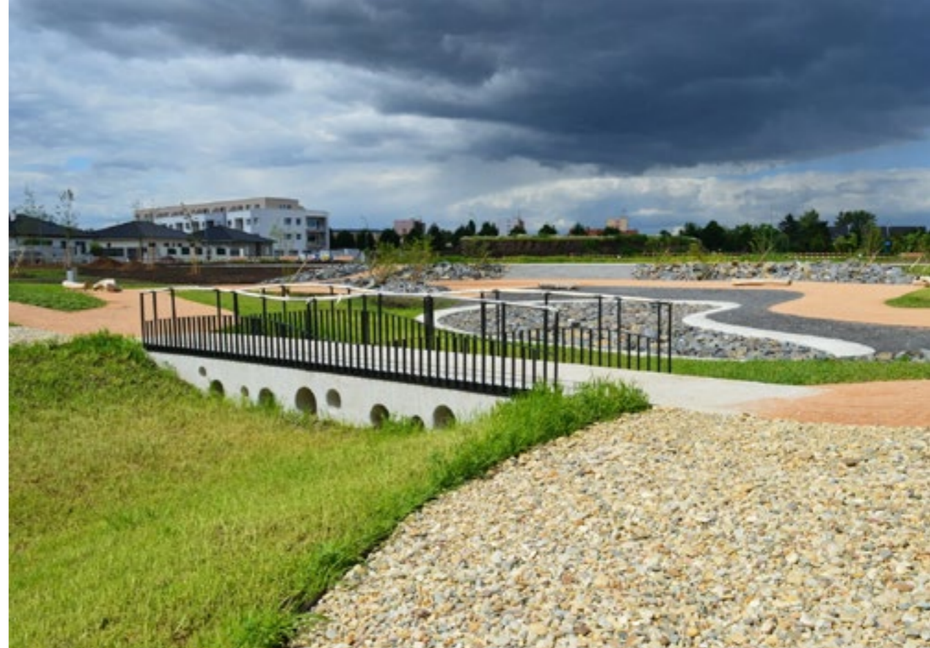
Mostek, otvory slouží pro cestu vody do poldru, když přeteče jezírko.
