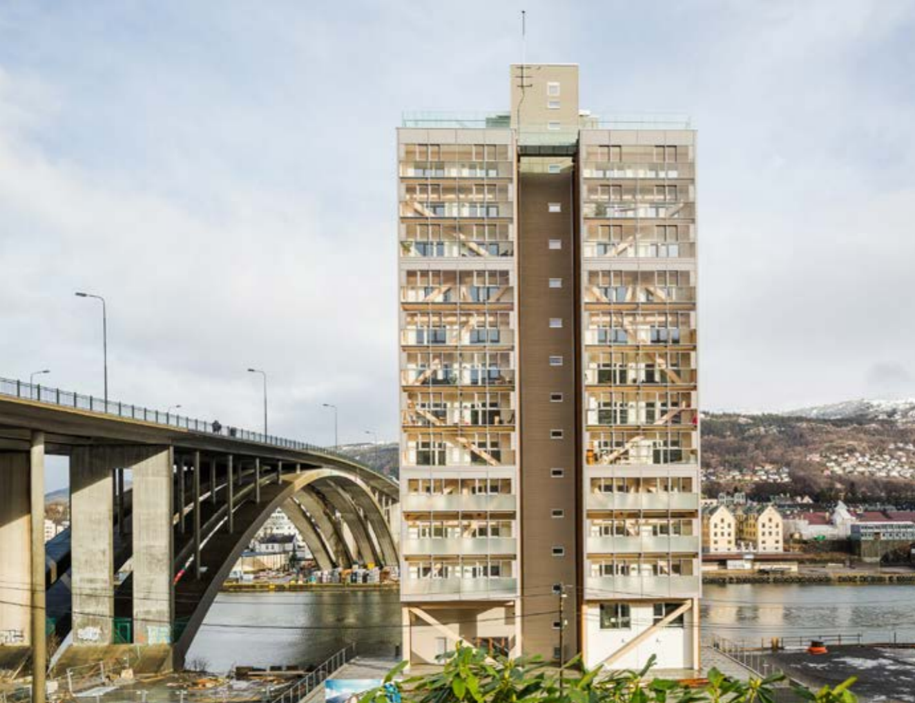
Nejvyšší bytová dřevostavba je čtrnáctipatrová rezidence v norském Bergenu od ateliéru ARTEC. Detail fasády při výstavbě , interiér bytu . (Foto: ARTEC)
