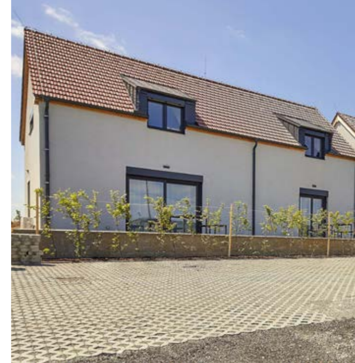
Eco apartmány s výhledem na nádrž Nové Mlýny a okolní pálavské vrchy jsou řešeny systémem panelové dřevostavby.
