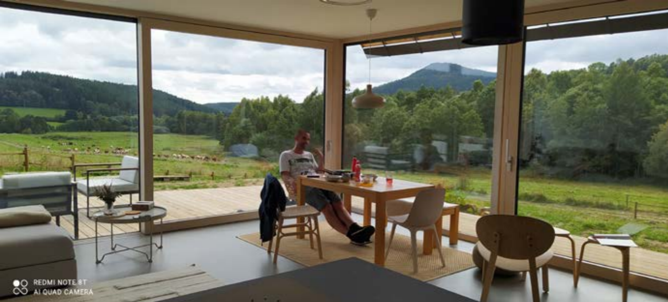
Velkoformátová dřevo-hliníková okna s izolačními trojskly obíhají v přízemí celou jižní a východní fasádu.
