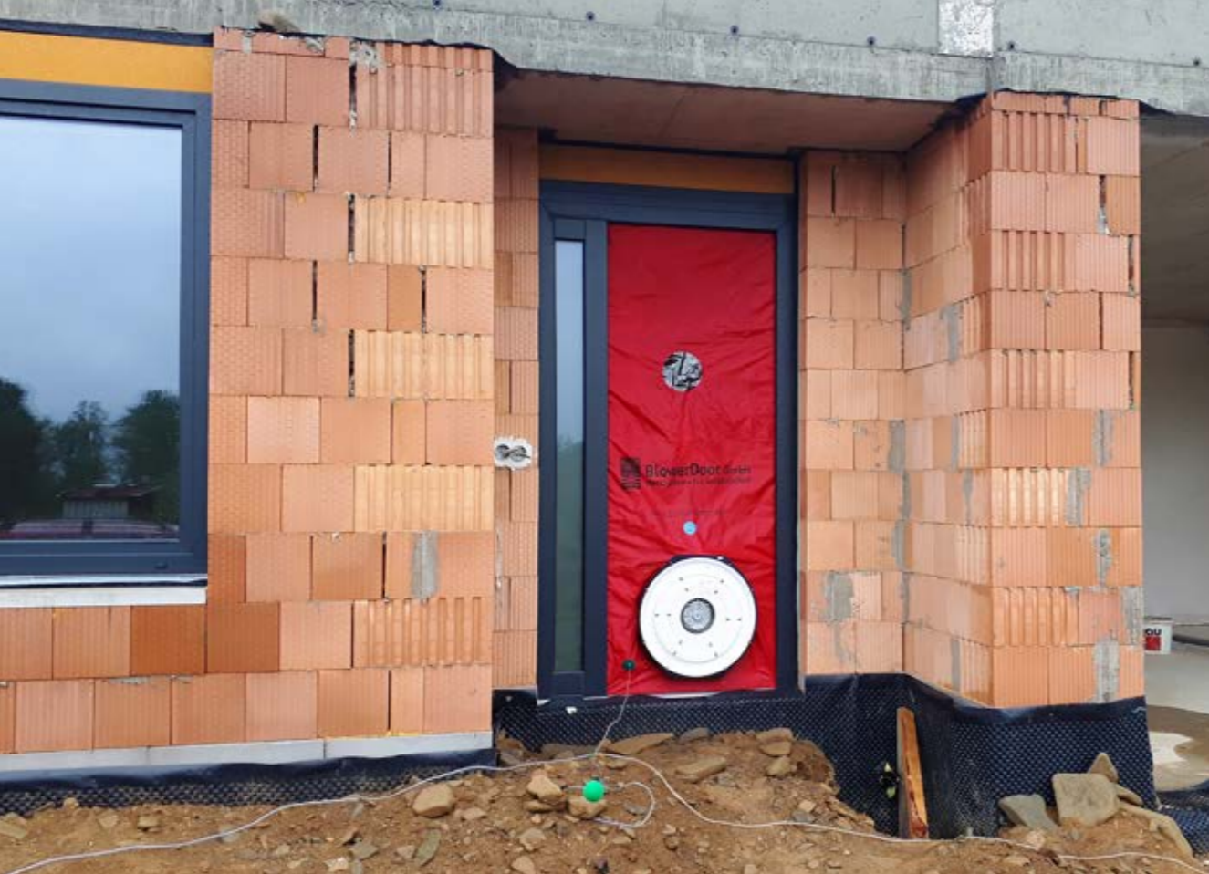
Blower door test je měření průvzdušnosti obálky budovy pomocí tlakového spádu.
