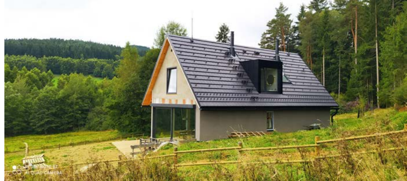
Severní část střechy pokrývají černé keramické tašky.
