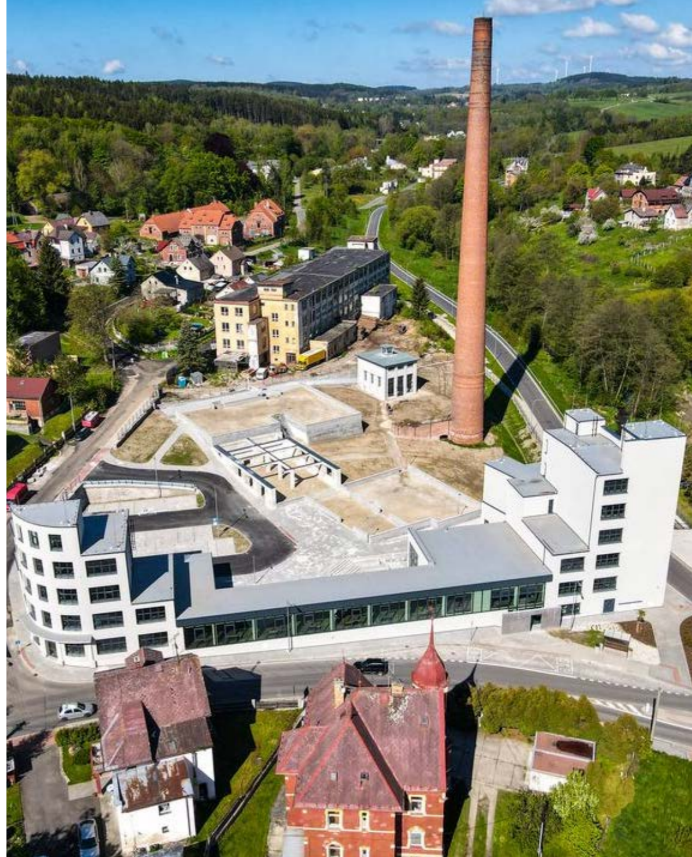
Konverze továrny Tosta v Plesné, realizace 2020.
