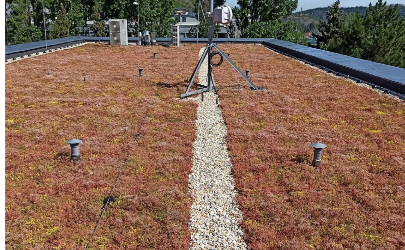
Zelená extenzivní střecha s rozchodníky na původní stavbě při omezené nosnosti konstrukce. Střecha se projevuje malou potřebou údržby vegetačního porostu a nenáročnými rostlinami. Výška substrátu: 30–150 mm, velmi nízké vrstvy pod 60 mm, nízké vrstvy 60–80 mm využitelné převážně pro rozchodníky, střední vrstvy 100–120 mm, vysoké vrstvy 150 mm – pro trávy a byliny. (Foto: autor)
