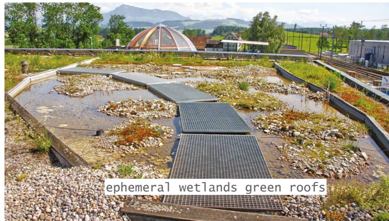
Modro-zelená střecha (wetland). Půdorys střechy . (Foto a půdorys: archiv Dusty Gedge)
