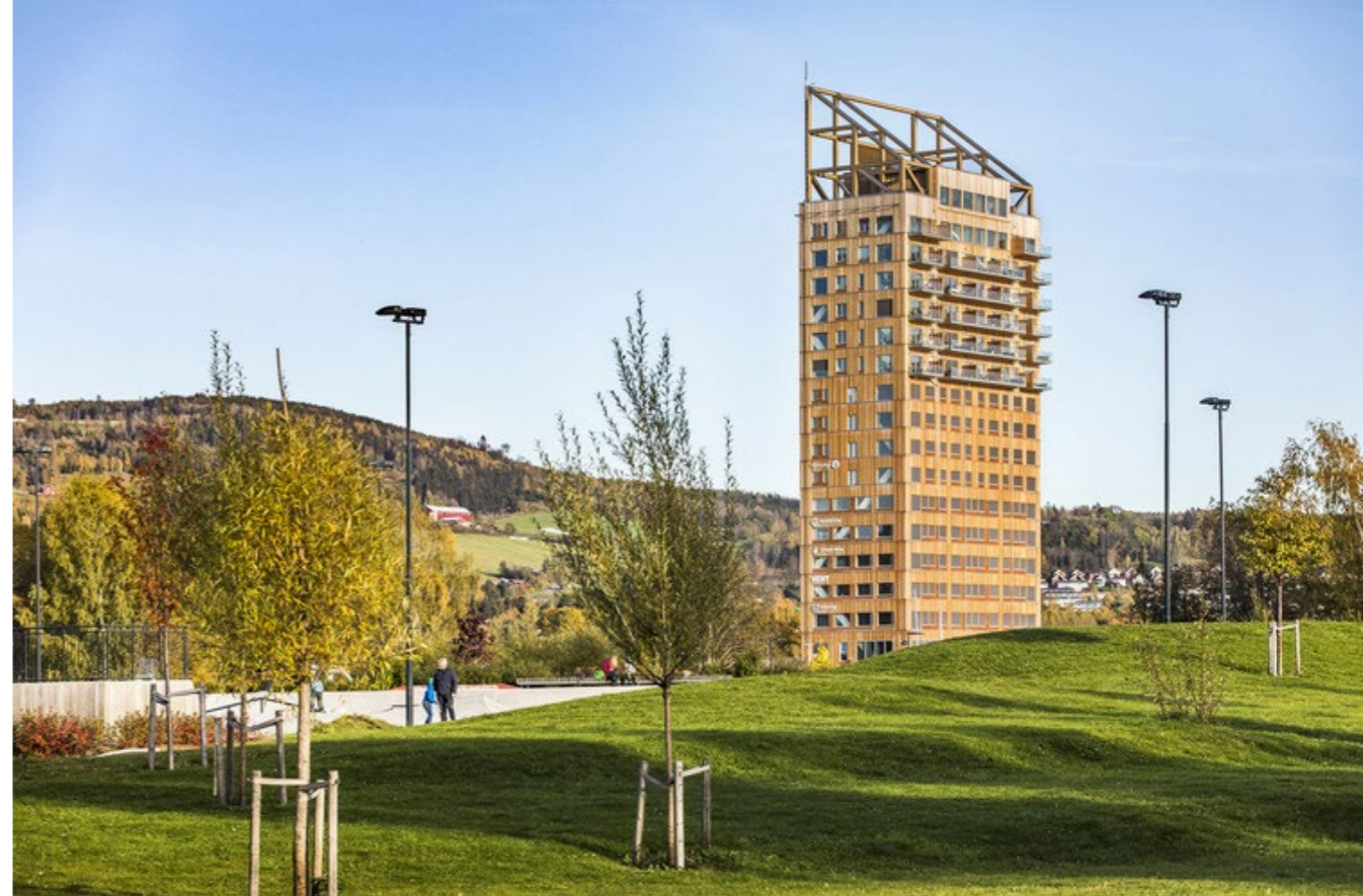
Devadesátimetrová dřevostavba Mjøstårnets byla postavena z CLT panelů v norském Brumunddal v roce 2019. (Foto: Moelven)
