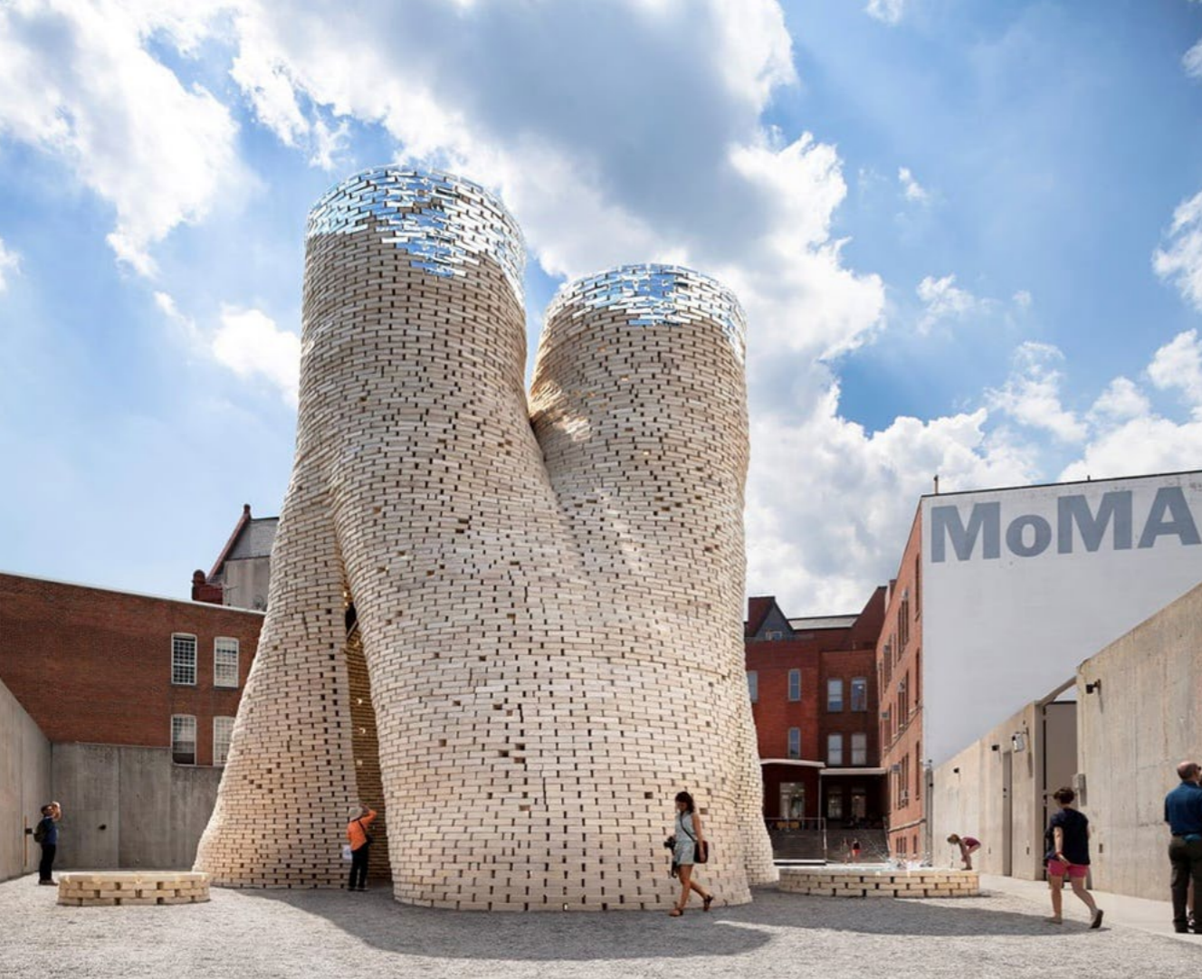
HyFi – houbová věž na nádvoří MoMA PS1 v Queensu v New Yorku z 10 tisíc cihel vyrobených z vláken hub, projekt: The Living, 2014. (Foto: BarkowPhoto)
