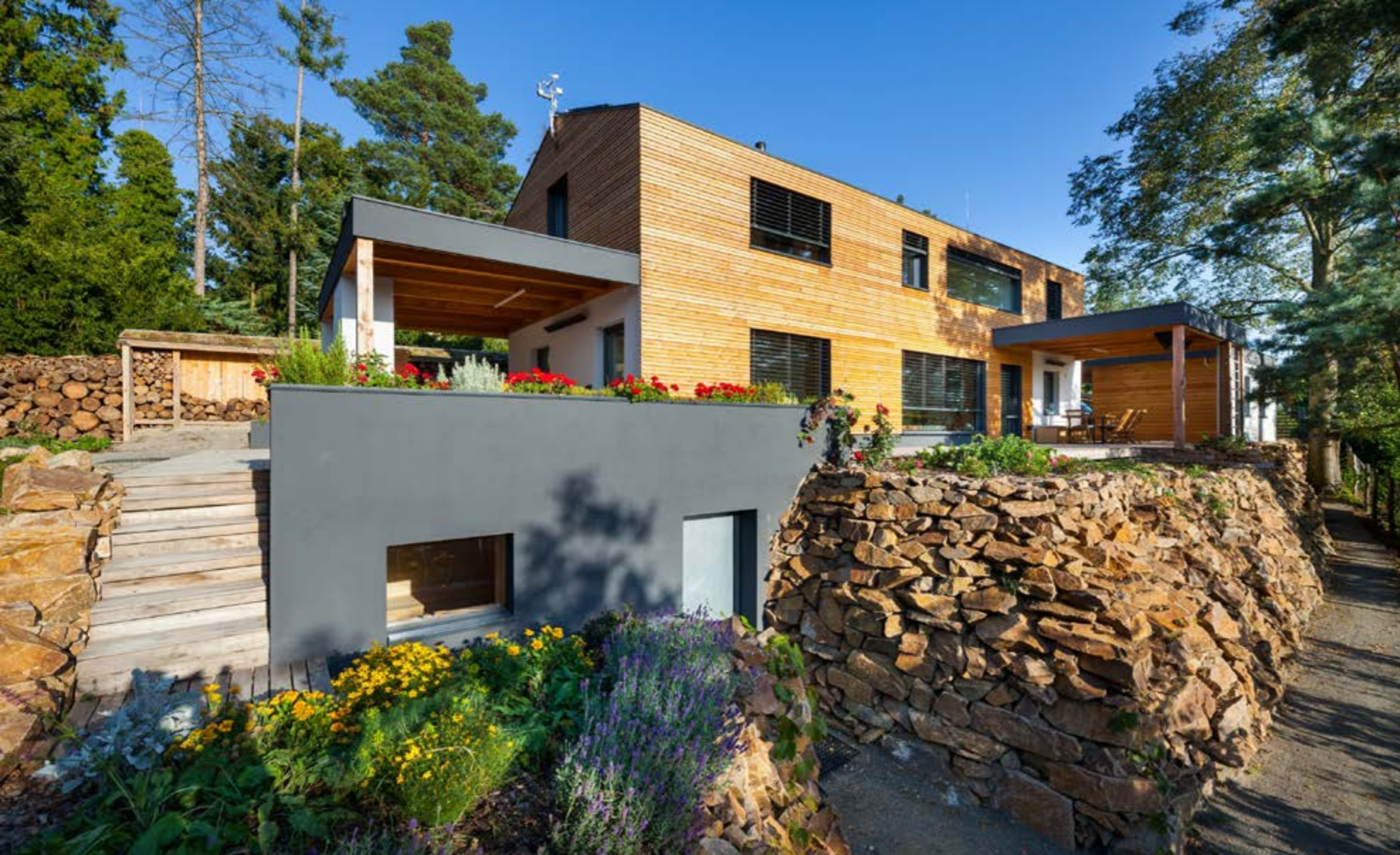
Rodinný dům v Omicích je vybaven bateriovou stanicí HES.
