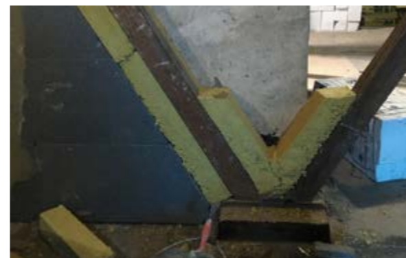
PŮDA: Odstraňování tepelných mostů na půdě a úprava římsy.
