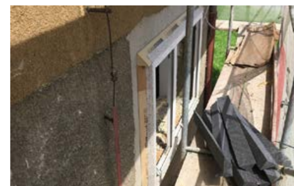
OKNA: Zateplování okolo oken, detaily osazení okna a parapetu okna .
