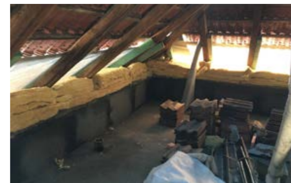
PŮDA: Odstraňování tepelných mostů na půdě a úprava římsy.
