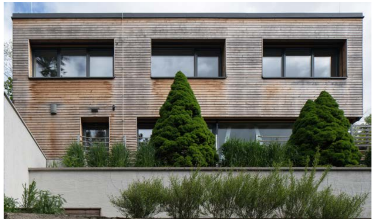
Na stavbu bylo spotřebováno 70 m 3 dřeva.
