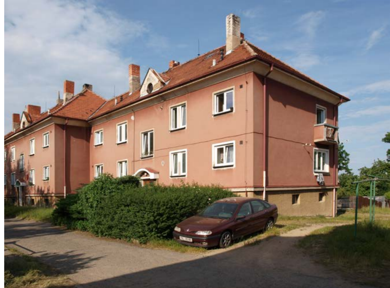
Původní stav domu, na vytápění se používalo uhlí, tepelné úniky se neřešily, na zdech se objevovaly plísně atd.
