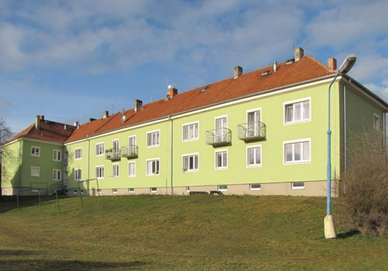
Stavební práce i v interiérech probíhaly při plné obsazenosti bytů.
