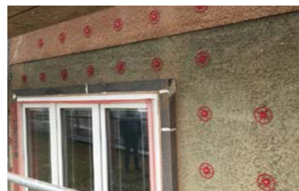
OKNA: Zateplování okolo oken, detaily osazení okna a parapetu okna .
