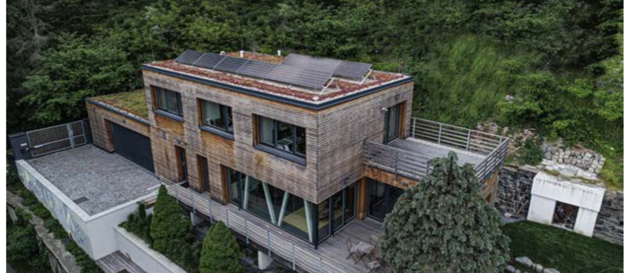
K ohřevu vody dům využívá také devět fotovoltaických panelů o výkonu 2,7 kWp.
