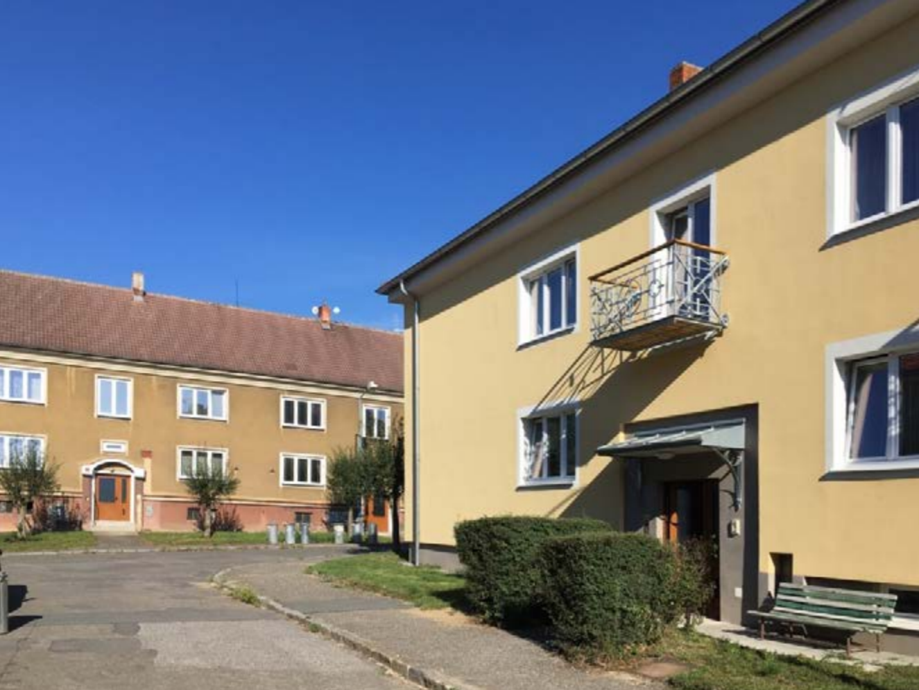
Vlevo původní stav bytového domu, vpravo budova po revitalizaci, včetně nového vstupu a balkonů.
