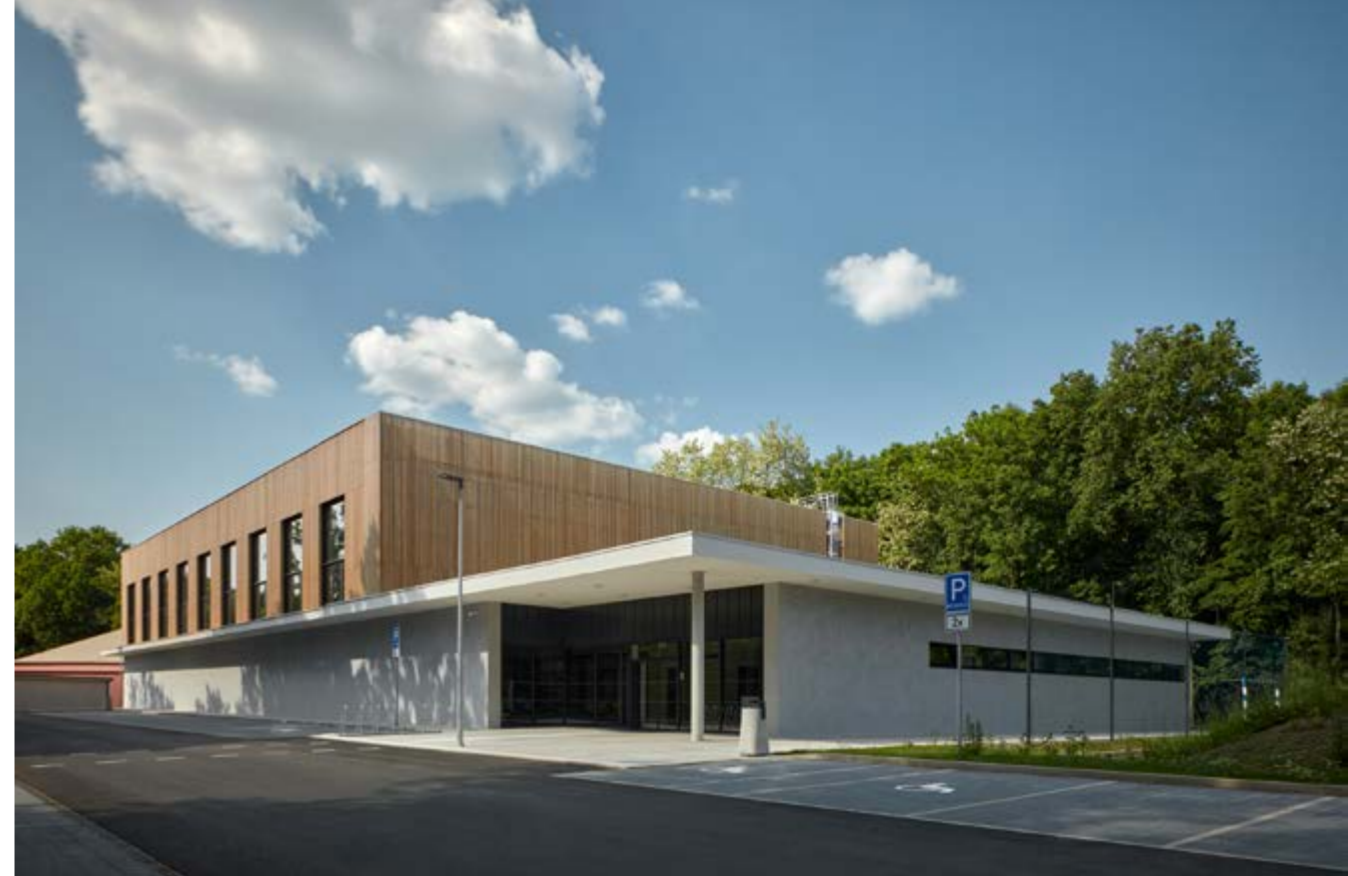
Na zázemí s šatnami a barem navazuje dřevěná převýšená konstrukce haly.
