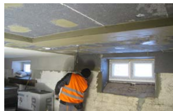
ZATEPLOVÁNÍ: Zateplování sklepů, integrované hnízdiště pro netopýry a rorýsy.
