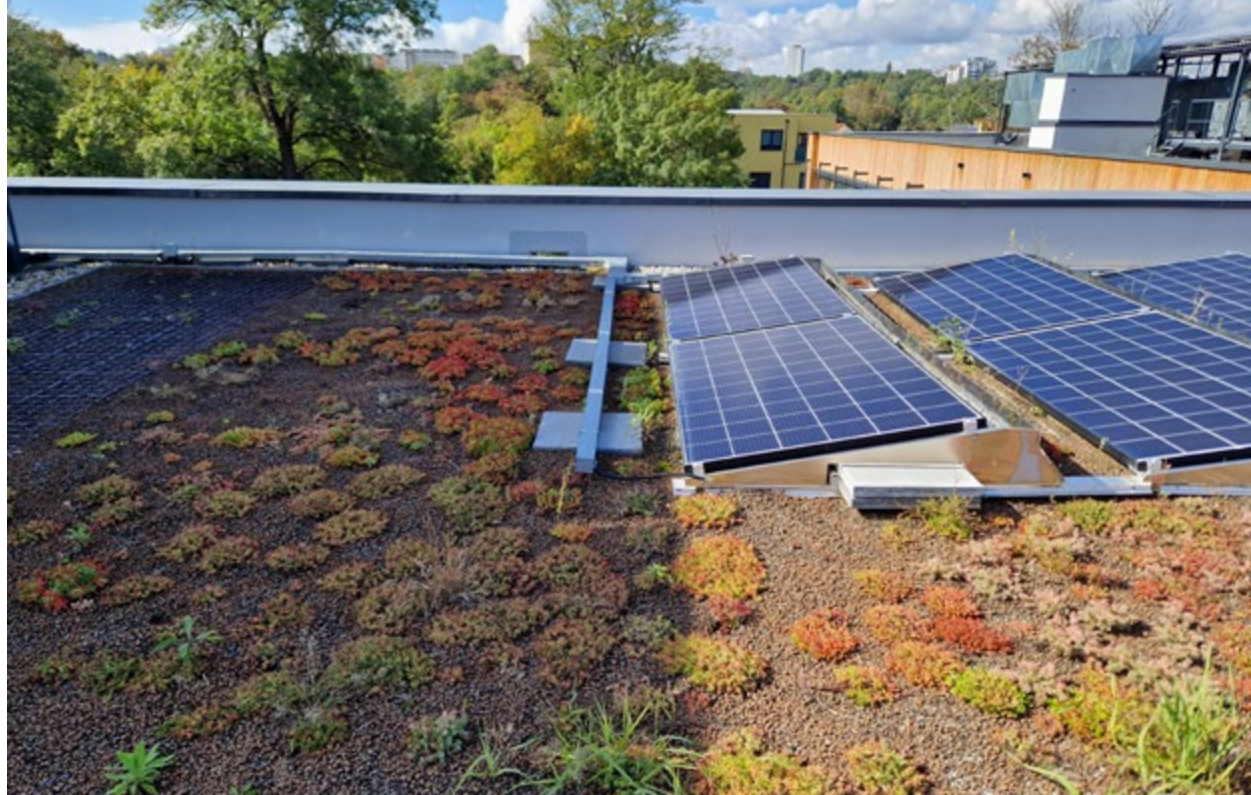
Střecha budovy je pojatá jako zelená extenzivní s fotovoltaickou elektrárnou elektrárnou o výkonu 147 kWp a pěti vzduchotechnickými jednotkami.
