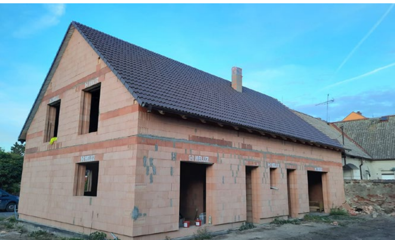
Stavba o 2.NP se sedlovou střechou – stropy nad jednotlivými podlažími mohou být zhotoveny ze systémem HELUZ MIAKO či HELUZ PANELY. Ve 2. NP v místě kleštin krovu.
