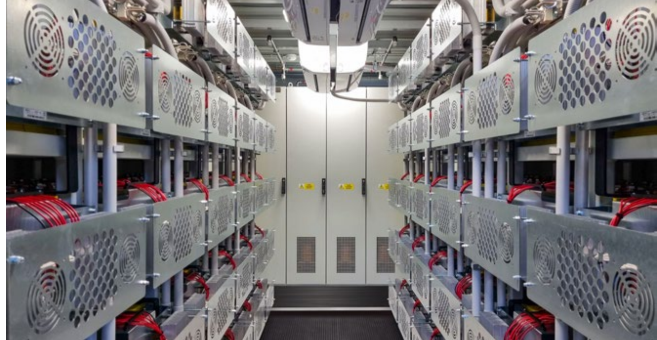
Pohled do interiéru kontejnerového bateriového úložiště SAS
