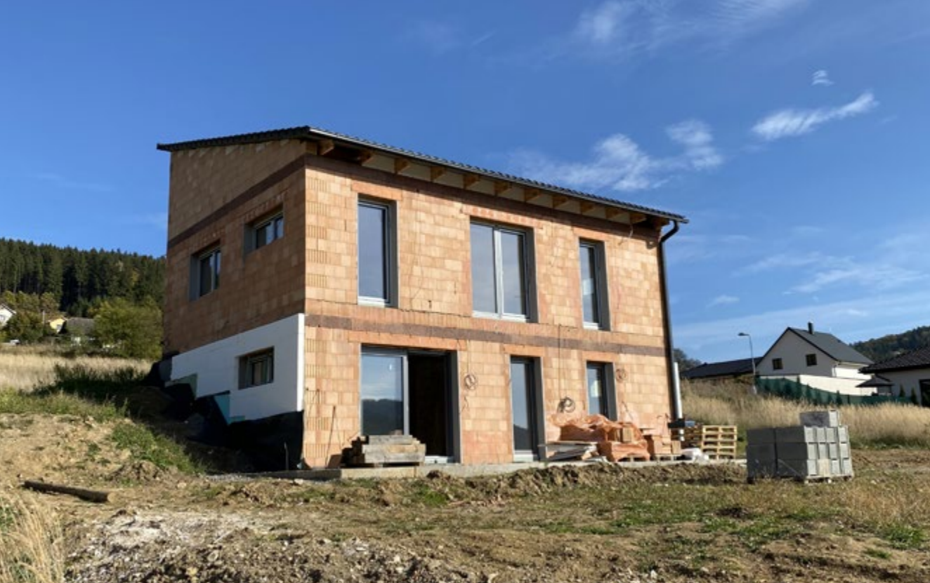
Stavba o 2.NP – stropy nad jednotlivými podlažími mohou být zhotoveny ze systému HELUZ MIAKO či HELUZ PANELY.
