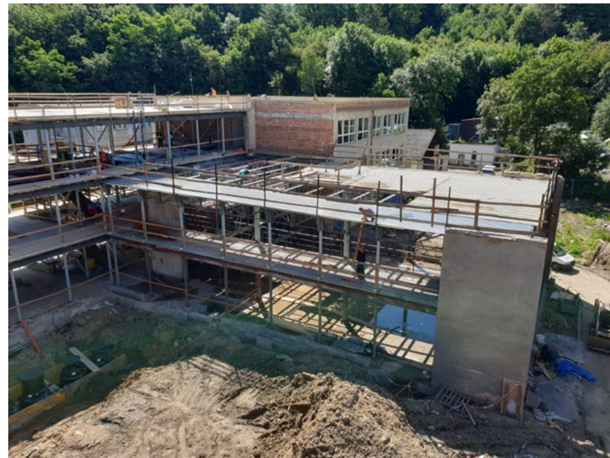
Konstrukčně se jedná o ocelový skeletový systém s příhradovými a plnostěnnými vazníky, který byl lokálně zesílen.
