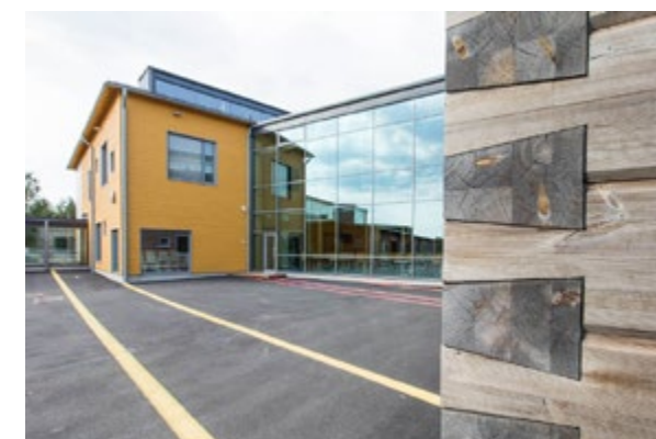
Vnější stěny jsou vyrobeny z 275mm dřevěných hranolů. (Foto: Alexander Kuzněcov)
