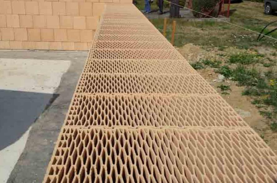
Cihelný střep tepelně-zolačných cihel HELUZ FAMILY má pevnost jako dobrý beton a tepelnou vodivost jako dřevo. Díky moderní výrobní technologii lze cihelný step vytvárovat tak, že cihly se hodí pro nízkoenergetické budovy bez vnějšího zateplení.
