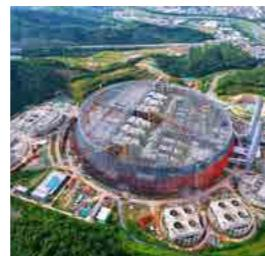
V jihočínském městě Šen-čen v provincii Guangdong vzniká největší zařízení na energetické využití odpadu na světě. Jeho výkon by měl dosáhnout 165 MW a denně bude schopen spálit 5 600 t tuhého komunálního odpadu.
