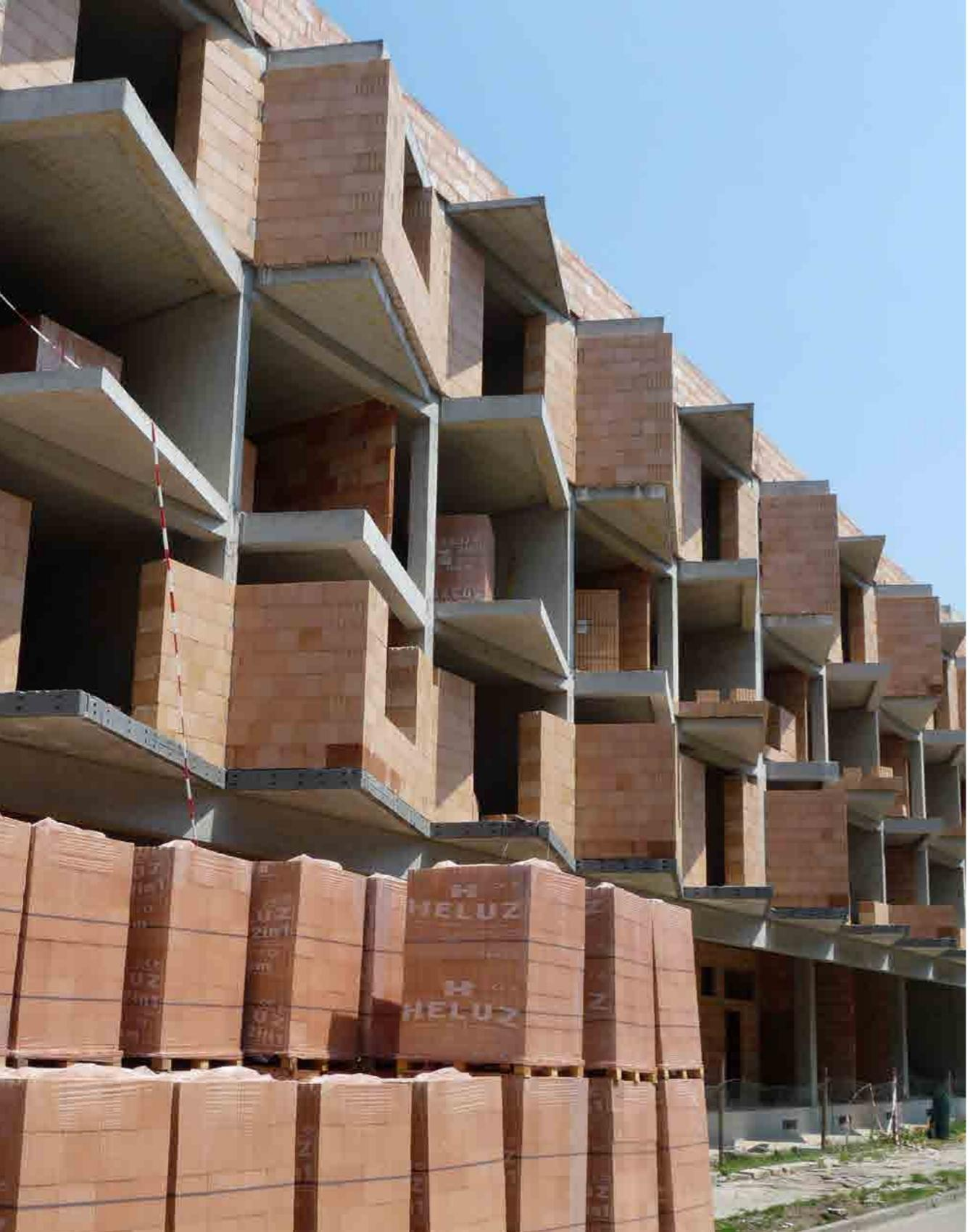
Moderní cihly HELUZ FAMILY 2in1 jsou vhodné pro obvodové konstrukce různých budov s důrazem na nízkou spotřebu energie na vytápění. Zde lázeňský dům v Poděbradech.
